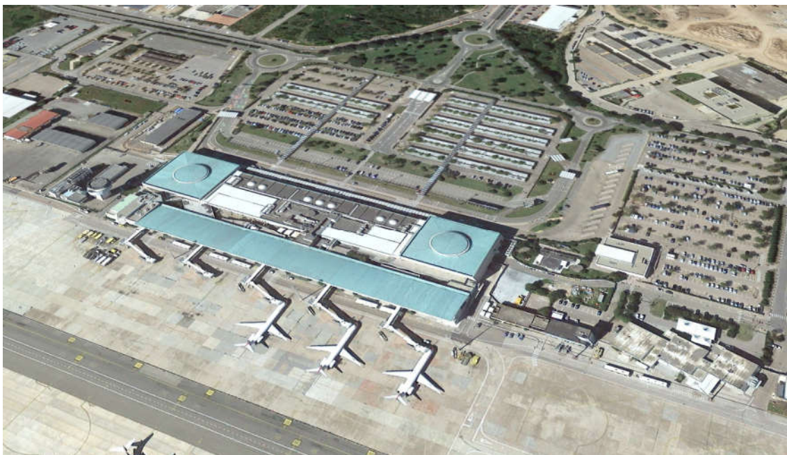
Vista aerea del terminal commerciale
